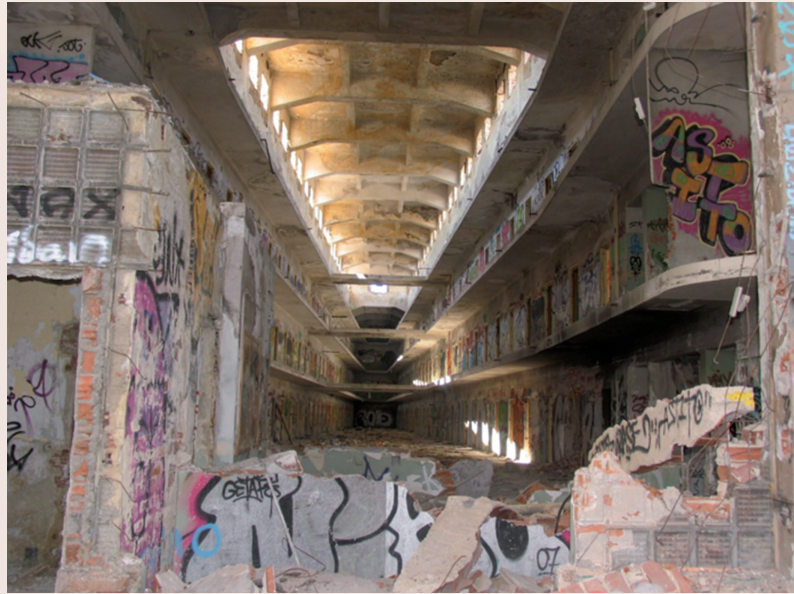
Galerías del centro penitenciario antes de su derribo (Fotografía del autor).
