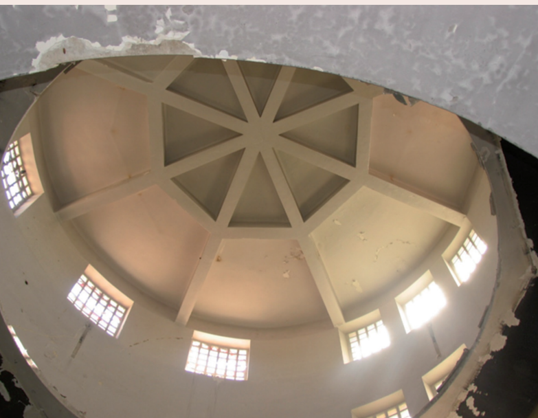
Cúpula del centro penitenciario antes de su derribo (Fotografía del autor).
